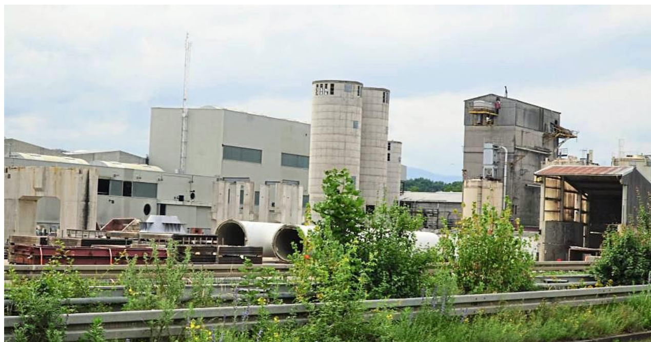
Resteverwertung: Alle Teile des Spanplattenwerkes in Bischweier sollen verschwinden und die Bürger über die Zukunft des Geländes mitentscheiden.
