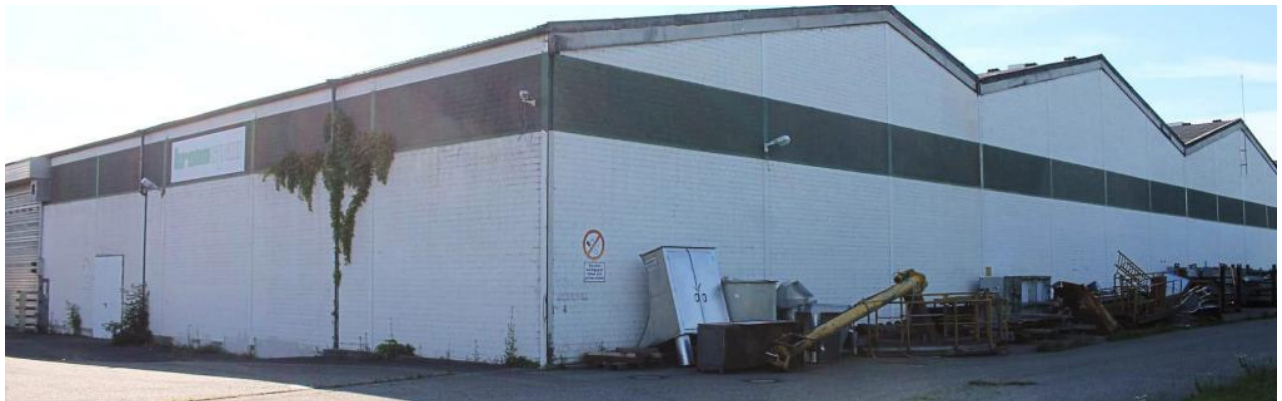
Neuer Bebauungsplan notwendig: Mit der Zukunft der Gewerbefläche des ehemaligen holzverarbeitenden Betriebs befasst sich der Bischweierer Gemeinderat. Die Produktionsanlagen sind mittlerweile abgebaut. Foto: Holbein
