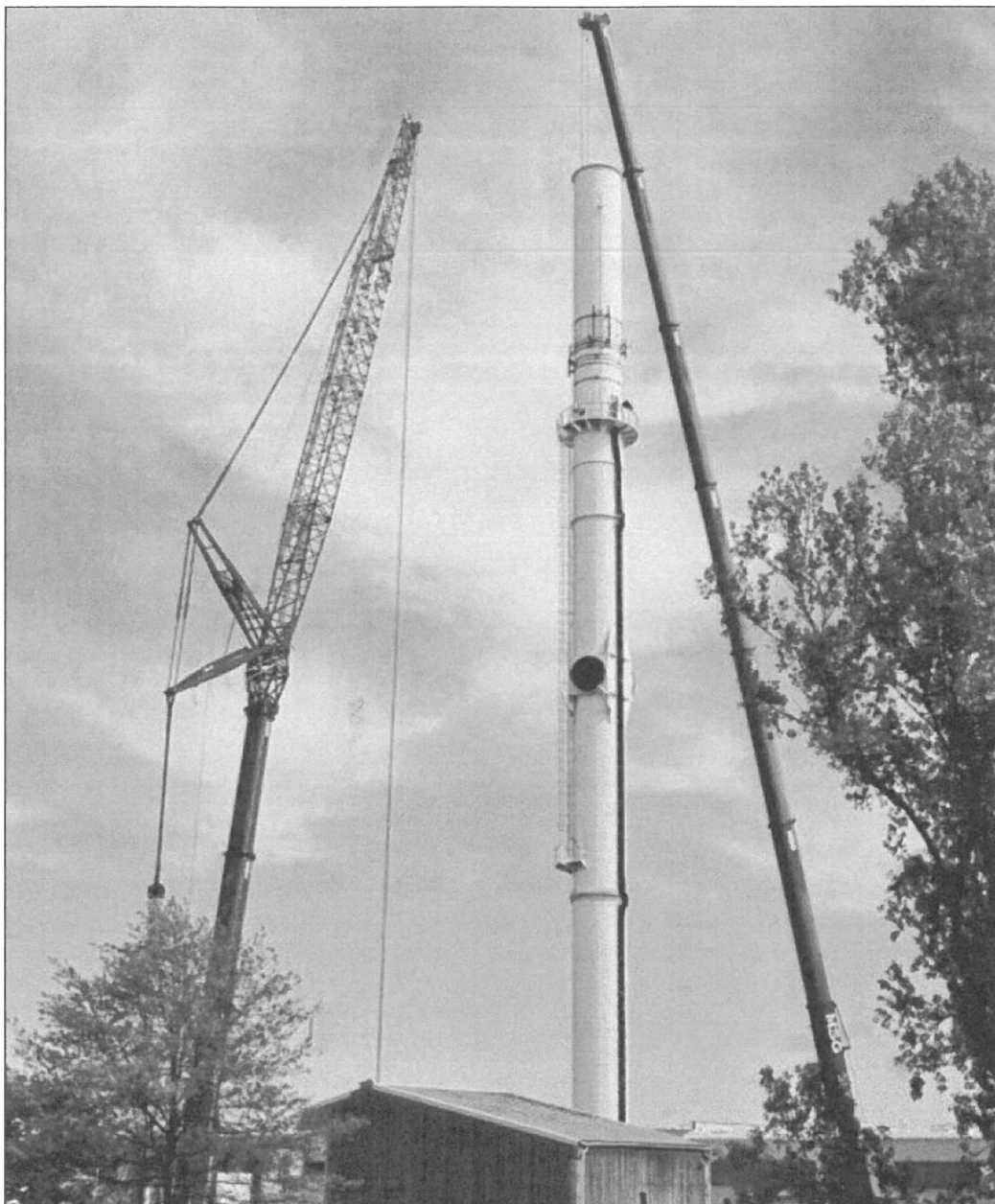
SYMBOLTRÄCHTIG: Der knapp 90 Meter hohe Schornstein des Spanplattenwerks der Firma Kronospan in Bischweier wurde gestern abgebaut. Foto: Collet
