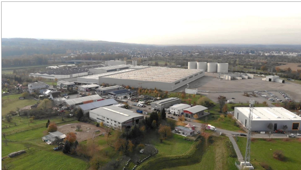
Abbildung 1-2: Schrägbild aus nordöstlicher Richtung auf das ehemalig Spanplattenwerk (10.11.2021)
